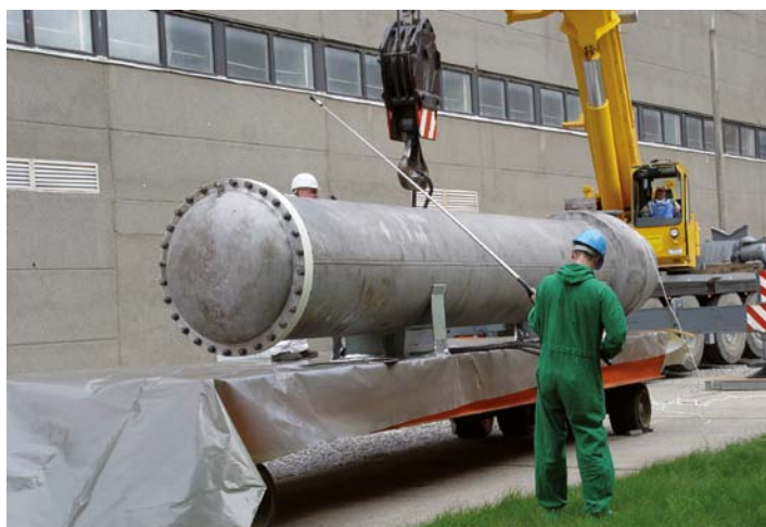
Abb. 38: Messung der Dosisleistung
