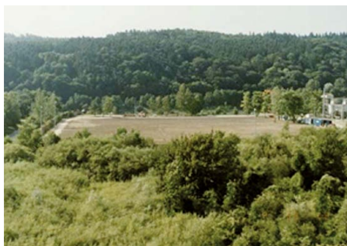
Abb. 1: Rückbau des Kernkraftwerks Niederaichbach
