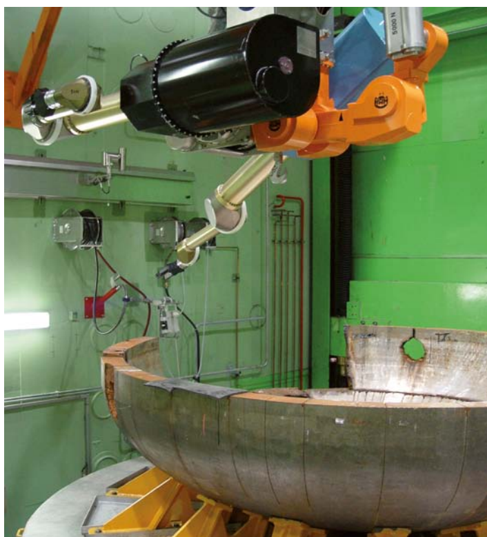
Abb. 29b: Fernhantiertes thermisches Schneiden (Kammer zur Trockenzerlegung)
