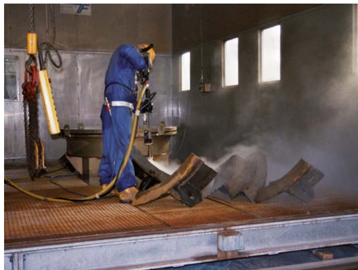
Abb. 26: Dekontamination mit Wasserstrahl
